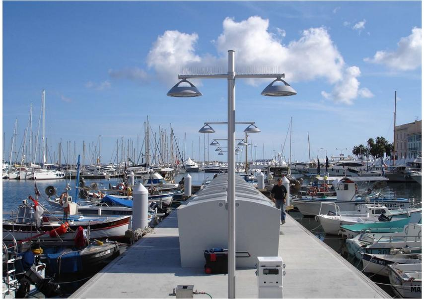
El Puerto Pesquero de Cannes mejoró significativamente con la remodelación completa de los muelles flotantes del puerto. Bellingham Marine se ocupó de la renovación que incluyó la sustitución de los pantalanes existentes por los modernos pantalanes flotantes de hormigón Unifloat® anclados con pilotes, actualizando las instalaciones de electricidad e iluminación y el sistema de agua potable de la marina.
